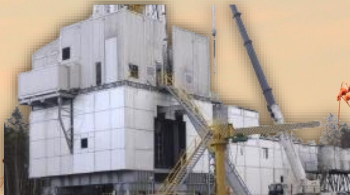
Укрытие каркасного типа буровой установки
