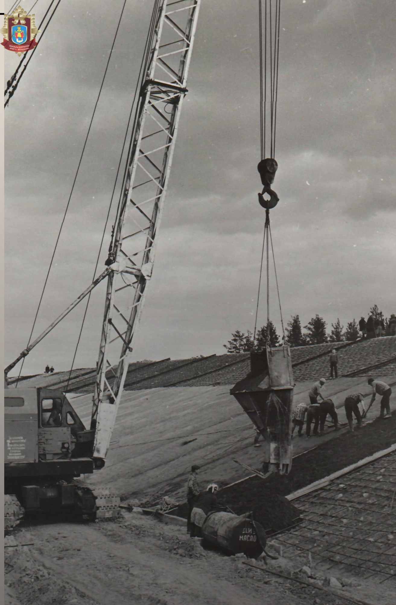
Бетонирование левобережной дамбы Вилейского водохранилища. 8 июля 1972 года
