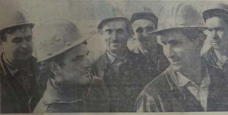
Группа рабочих передовой бригады плотников-ополубочников, которой руководит И. Р. СОНЧЕ. Они сооружали водосброс и насосную станцию первого подъема. Фото П. Новаторова. (БЕЛТА).
