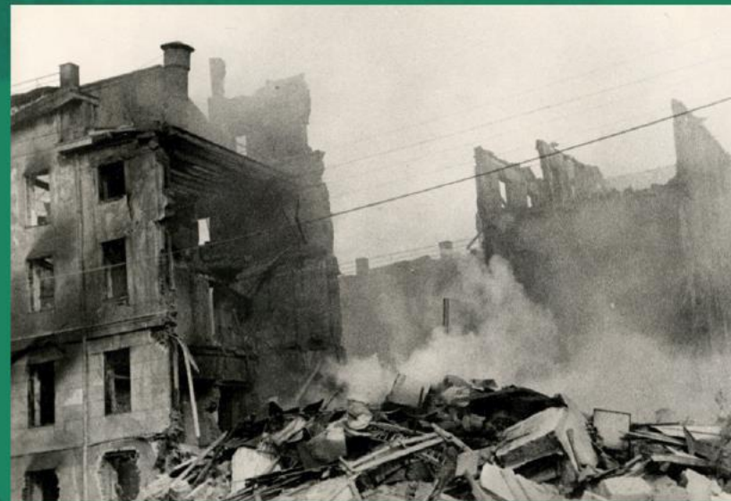
Руїны будынка ЦК КП(б)Б па вул. К. Маркса. 1944 г. БДАНТД.
