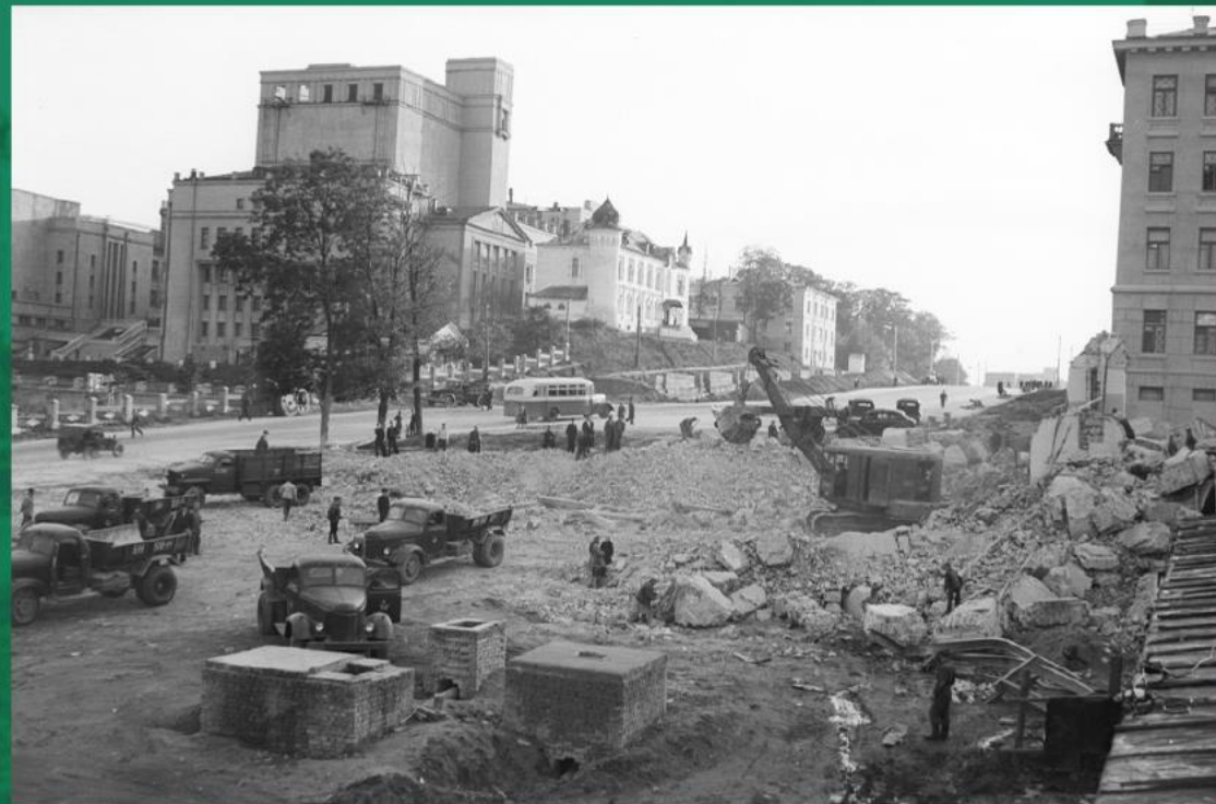
Будаўнічыя работы па вул. Савецкай. 1950 г. БДАКФФД.
