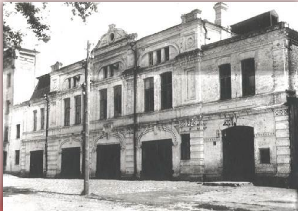
Фото. Пожарное депо в Бобруйске
