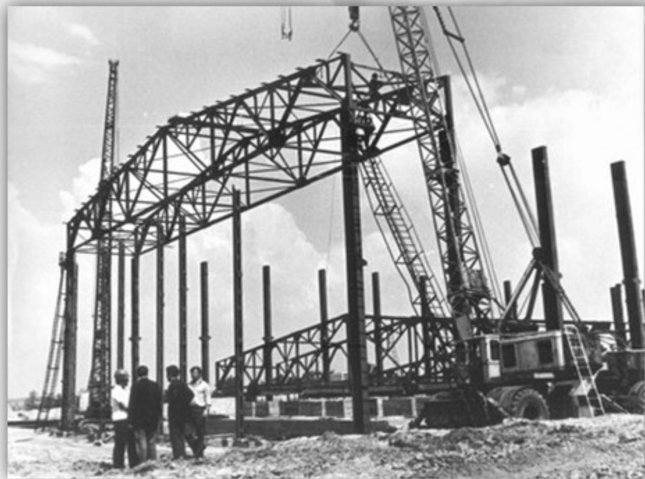
Начало строительства солевыварочного комбината
