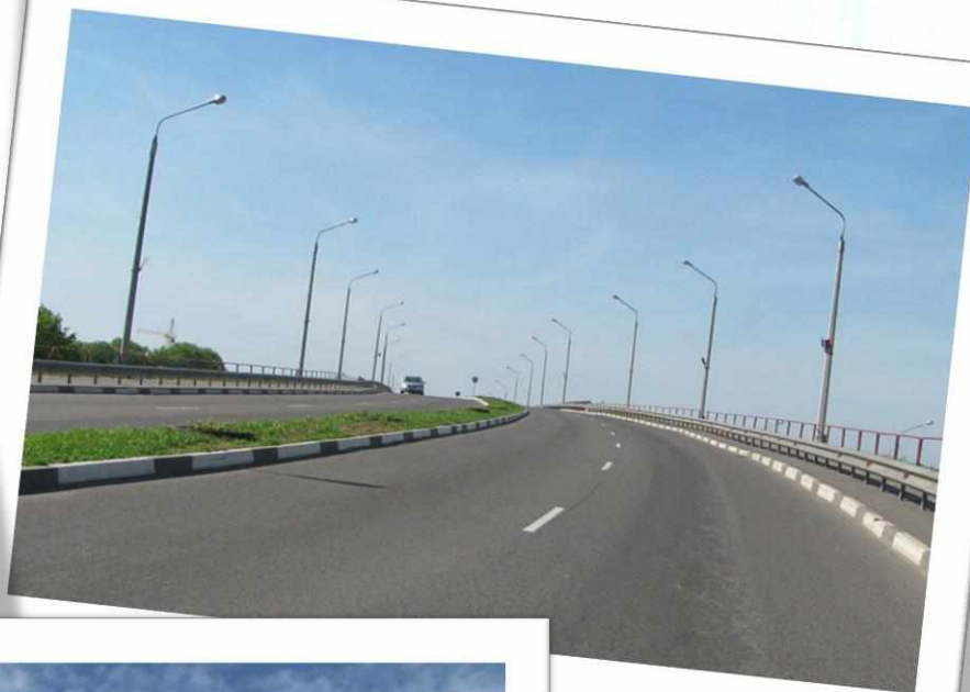
Автомобильный путепровод над железной дорогой
