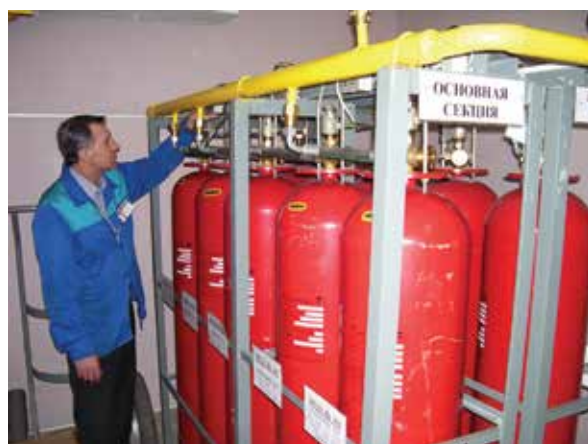
система газового пожаротушения
