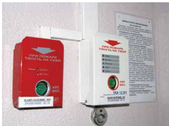
система газового пожаротушения
