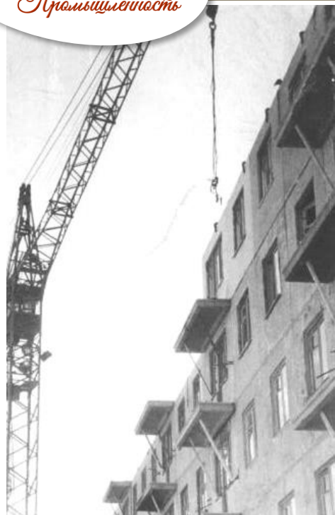
Строительство первого крупнопанельного дома в Октябрьском микрорайоне. 1963 г.
