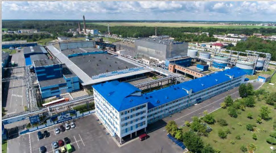
Технология производства основана на методе выпаривания соли из очищенного рассола. В 2014–2016 годах предприятие модернизировано, производственные мощности увеличены до 480 тыс. тонн
