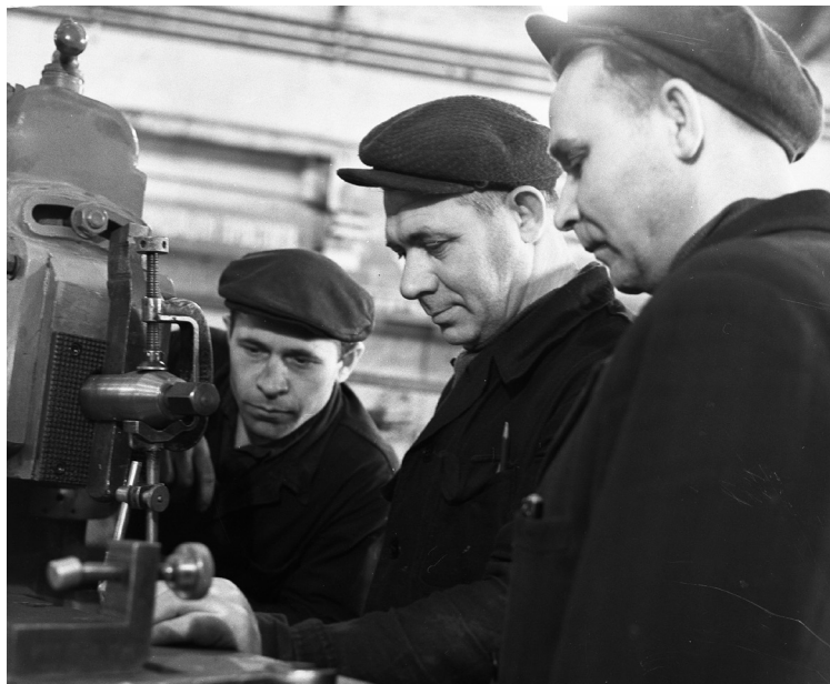
Мастер сборочного цеха Гомельского станкостроительного завода им. Кирова А. Я. Орлов, контрольный мастер Е. Г. Райский и слесарь-сборщик В. А. Селинов проверяют качество сборки поперечно-строгального станка на 1-й в республике поточной линии, 1964 г., г. Гомель, Фототека БелТА
