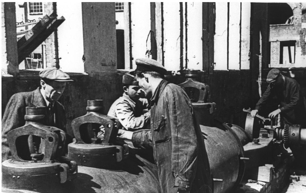
Начальник строительства Речицкого домостроительного комбината Румянцев и бригадир-монтажник паровой машины Кандеев за монтажом паровой машины в силовой станции, 1964 г., обл. Гомельская, ЦГАКФФД СССР
