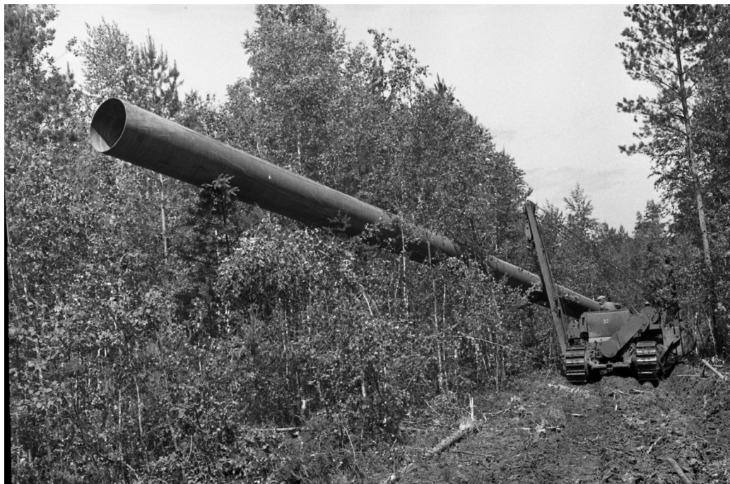
Укладка нефтепровода «Дружба» в р-не г. Житковичи, 1962 г., Житковичский р-н, Коллекционер В. Я. Китас
