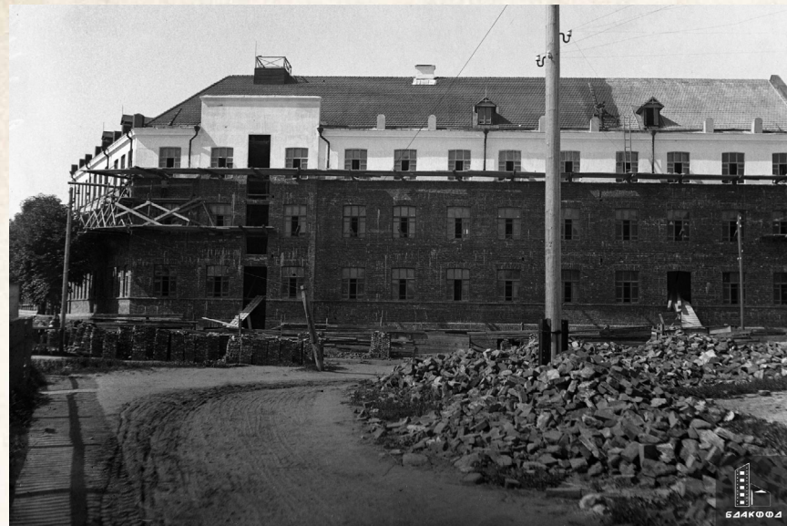
Строительство центральной бани на улице Лобазной (не сохранилась, район современных домов № 47 по улице Ильинского и № 13/34 по улице Зеньковой). Июль 1931 года (БГАКФФД, 2-0144)
