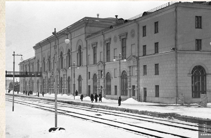
Вид на здание нового вокзала. 26.11.1952 года (БГАКФД, 0-004823)
