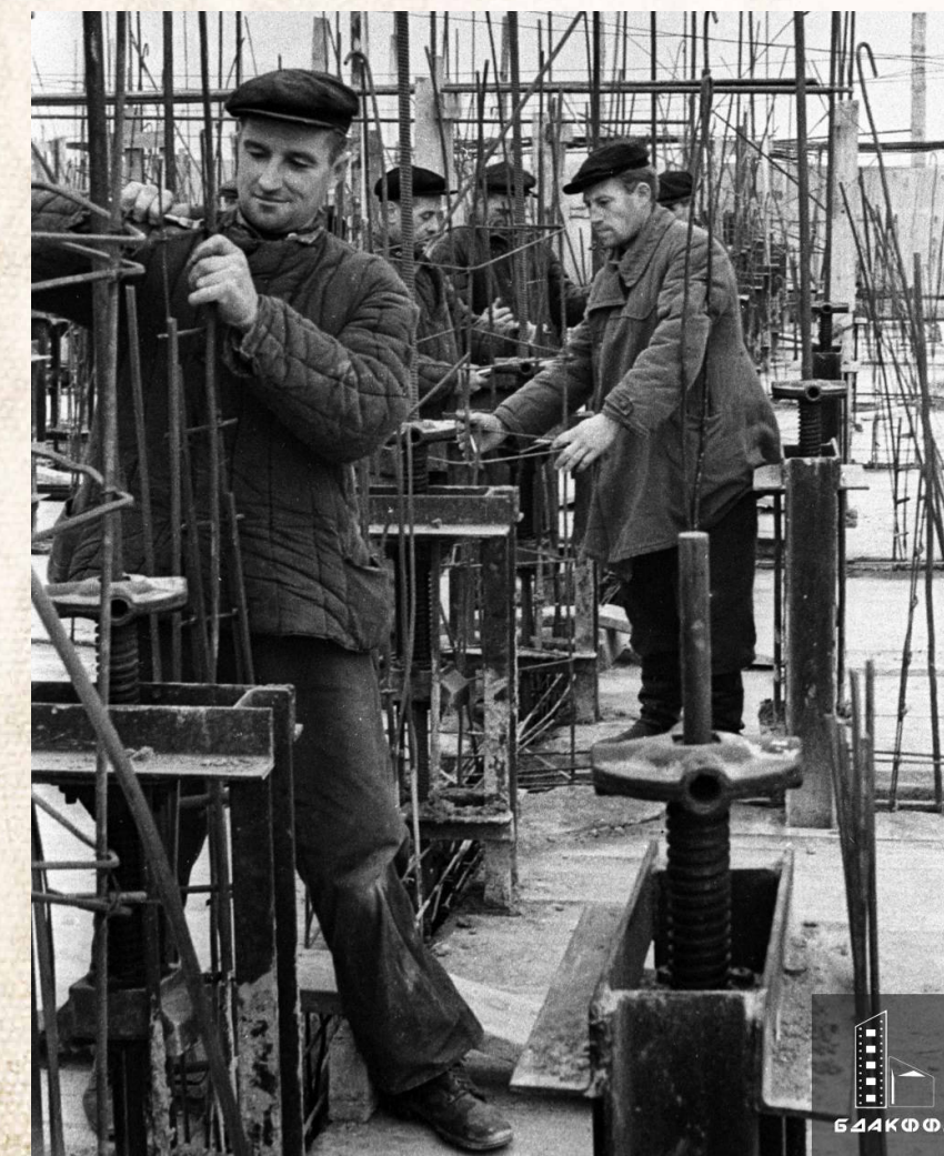
Бригада арматурщиков на строительстве элеватора для Витебского мелькомбината (современный Витебский комбинат хлебопродуктов). 23.10.1951 года (БГАКФФД, № 0-005153)
