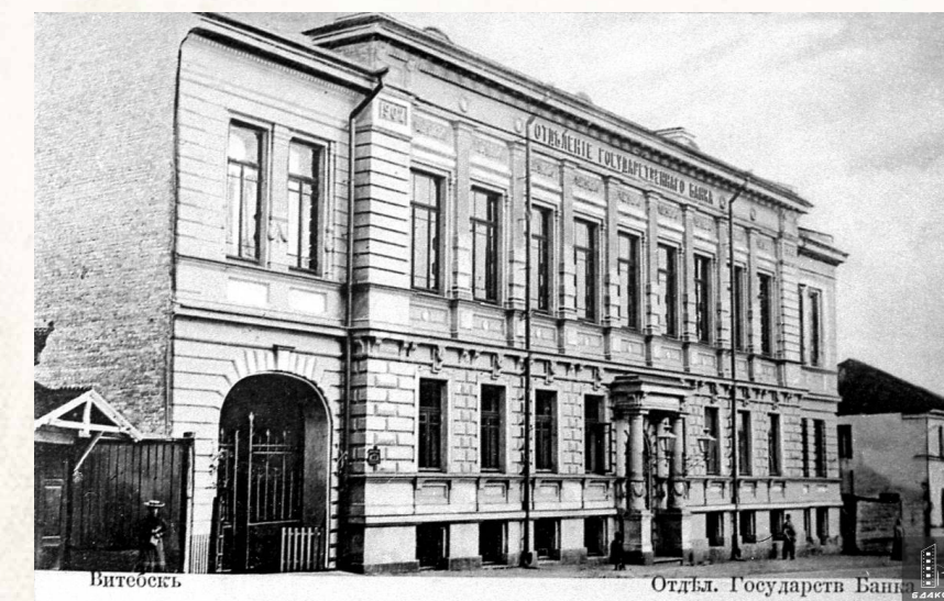
Здание отделения Госбанка в городе Витебске на улице Замковой через дорогу (южнее) от Благовещенской церкви. После 1902 года (БГАКФФД, 0-121068)
