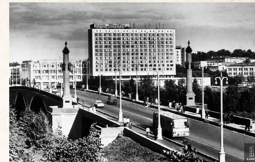
Вид на Кировский мост и на гостиницу Витебск. 1982 год (БГАКФФД, 0-131396)
