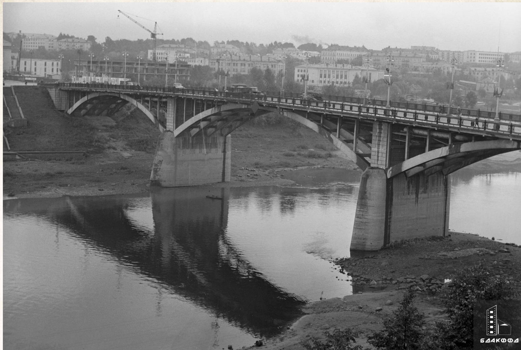
Вид на Кировский мост и на строительство гостиницы «Витебск». 1970 год (БГАКФД, 0-077049)
