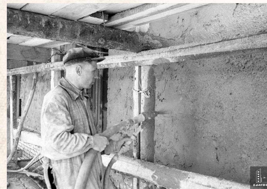
Каменщик П.Бутанов на строительстве вокзала в городе Витебске. 1950 год (БГАКФД, 0-009633)
