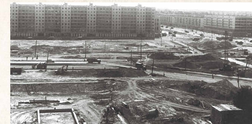
Идет строительство площади Победы. Начало 1970-х годов
