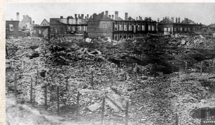
Руины жилых домов на углу улиц Вокзальной и Нижне-Петровской (современный район пересечения улиц Кирова, домов № 12, № 14/22 и Комсомольской, дома № 15) в городе Витебске в годы Великой Отечественной войны. На заднем плане в центре – разрушенное здание современного офиса ОАО «Веста» (по улице Комсомольской дом № 15). 1944 год (БГАКФФД, 0-029558)
