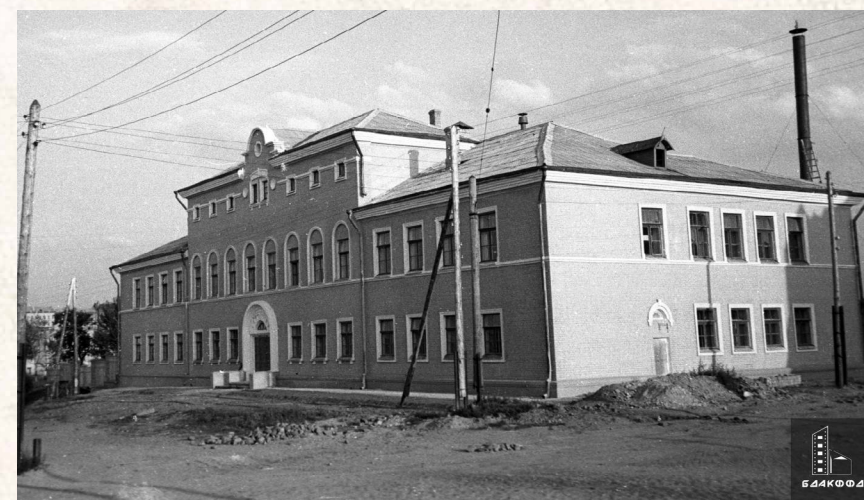
Вид на здание новой бани по улице Зеньковой. 1951 год (БГАКФФД, 0-006388)
