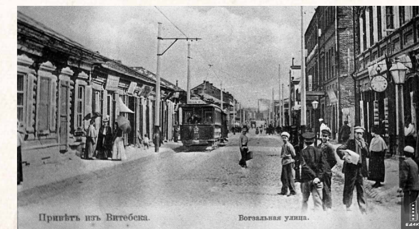
Вокзальная улица (правобережная часть, вид от улицы Канатной (современной улицы Димитрова) к Двинскому мосту). Начало XX века (БГАКФФД, 0-109881)
