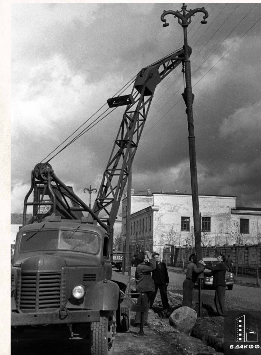
Установка металлических опор для электроосвещения на улице Димитрова. 13.09.1952 года (БГАКФФД, № 0-006673)
